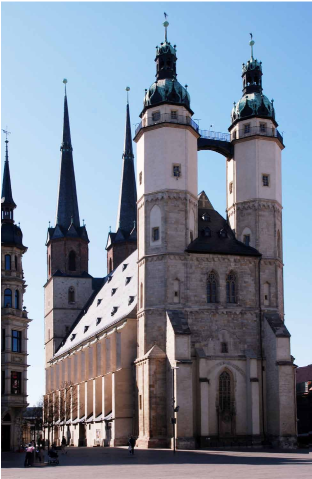
Blick vom Marktplatz auf die Marktkirche zu Halle
