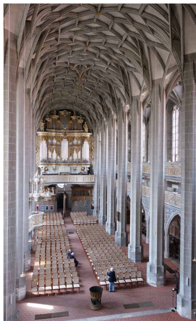
Die schlanken Säulen tragen das filigrane Gewölbe
